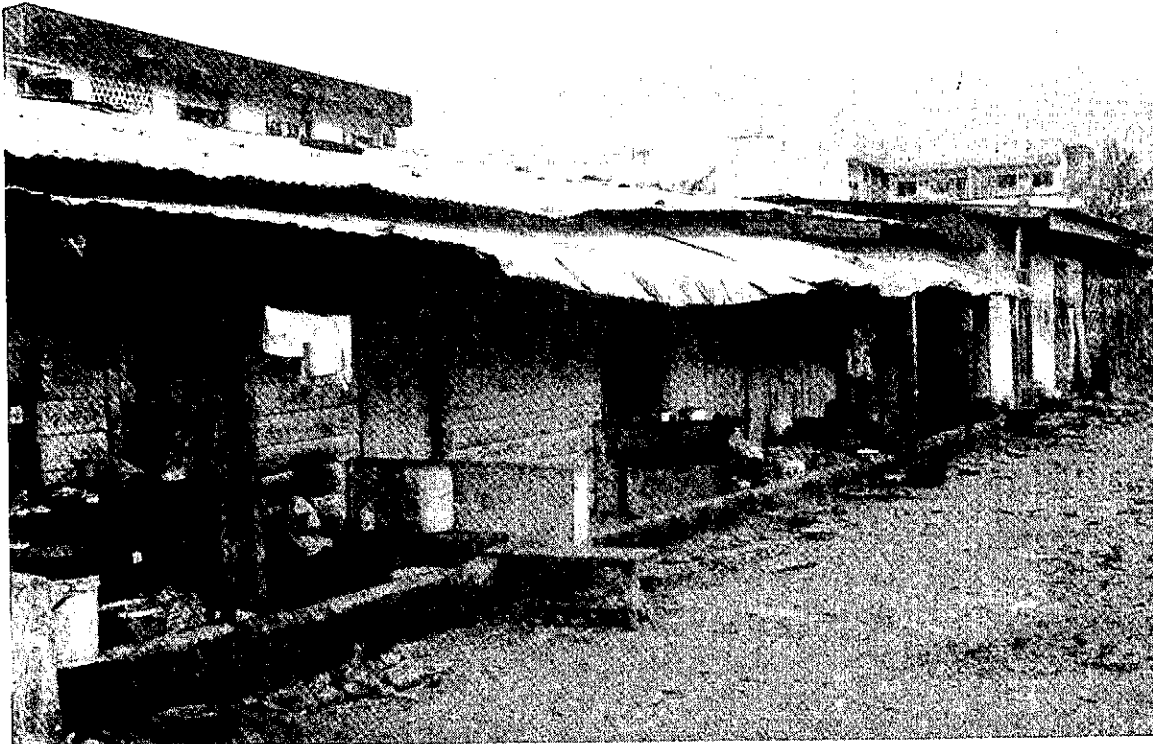
Murets protecteurs devant des maisons régulièrement inondées.
